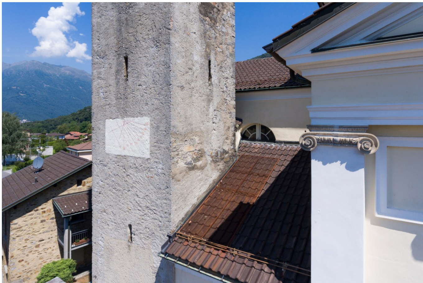
Vista del campanile dopo del restauro
