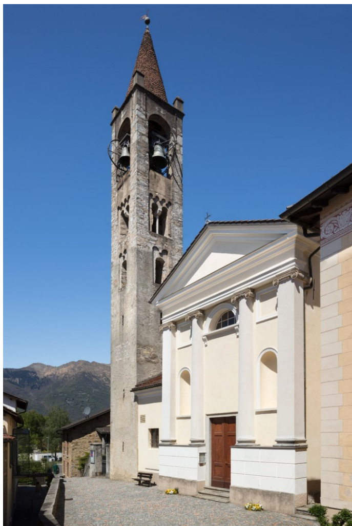
Facciata chiesa Sant'Ambrogio prima del restauro
