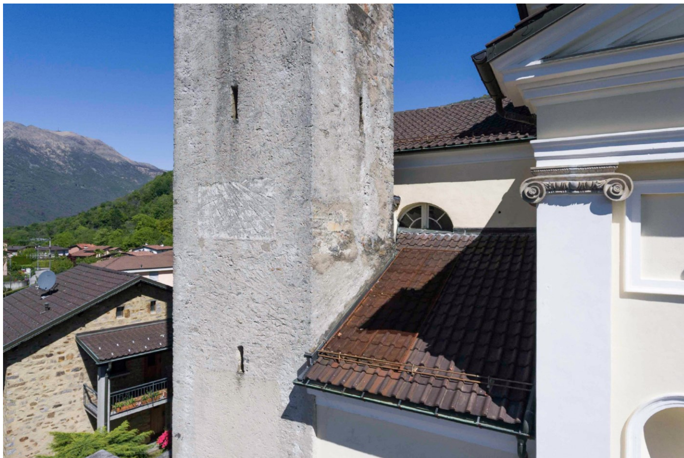
Vista del campanile prima del restauro
